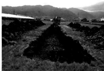
トレンチ掘削状況 (西より)
