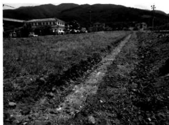
2号トレンチ完掘状況 (西より)
