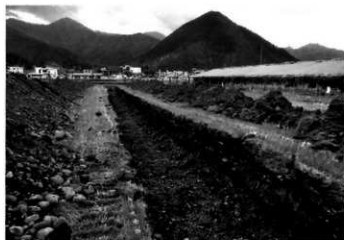
トレンチ完掘状況 (東より)
