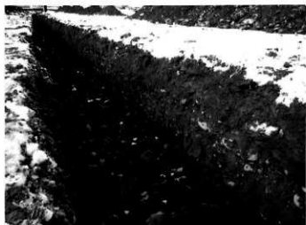
トレンチ完掘状況 (南東より)
