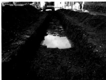
トレンチ完掘状況 (東より)
