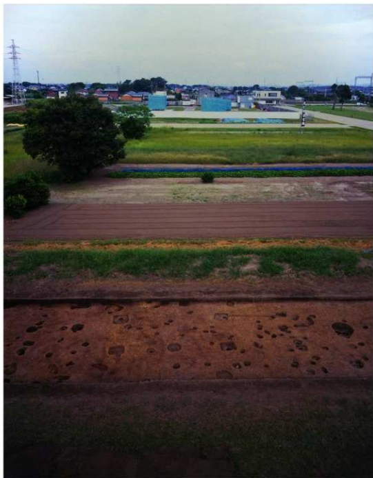
S B10289と工事中の「さいくう平安の杜」復元建物
