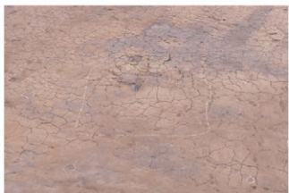
竪穴建物 ST6071 検出状況 西から
