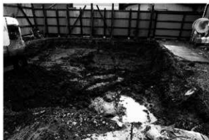
4 表土除去中 (西から)
