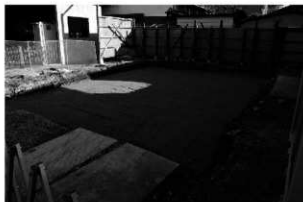
13 調査区埋戻し後（南西から）
