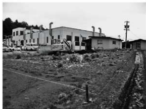
図版 13 調査前現況(南西から)
