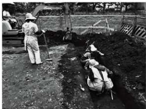
図版 28 調査風景 (北から)
