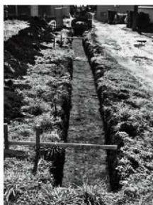
図版25 トレンチ掘削状況(北から)
