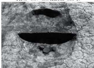
写真 34 SK90 掘削状況 (西から)
