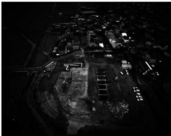
22次調査区全景 西から
