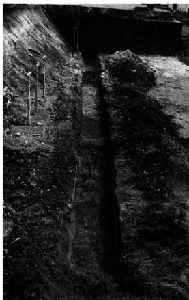
19次調査区試掘トレンチ全景 西から
