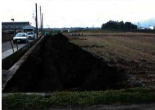
写真 28 東西トレンチ掘削状況（東から）
