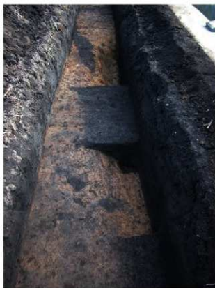
写真 32 SK317・SD318 掘削状況（西から）
