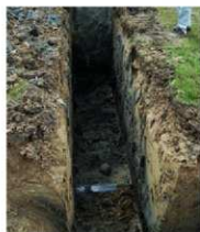
写真12 g地点掘削状況（北から）
