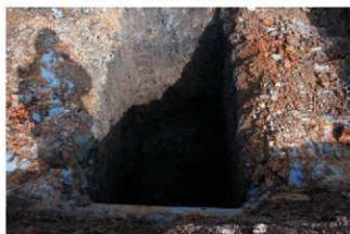
写真7 c-1地点掘削状況（南から）
