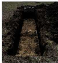
写真13 h地点掘削状況（北から）
