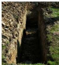
写真11 g地点掘削状況（西から）
