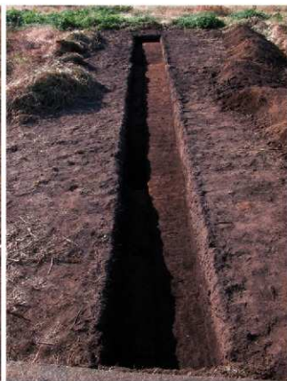
写真1 1トレンチ掘削状況（東から）
