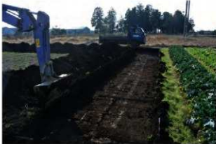
Fig.8 南北トレンチ表土除去 (北から正面に政府跡)
