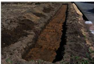
3 1トレンチ 西から
