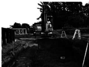
重機による表土剥ぎ
