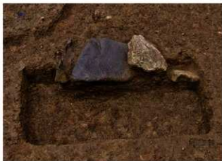
ST01 礎石13 断ち割り (東から)
