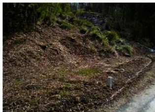
玉川開の崖 調査前風景 (北西から)
