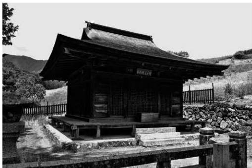
現存仏堂（長野県下伊那郡大鹿村福徳寺本堂 室町時代前期 重要文化財 河西撮影）
