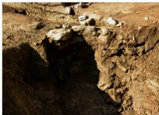
SE01 断ち割り (南西から)
