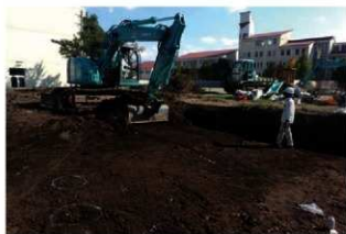
重機による表土掘削
