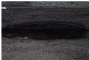
SB16 A-B断面(南より)
