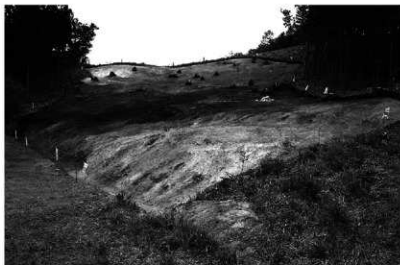
調査区（表土除去後）・SW→
