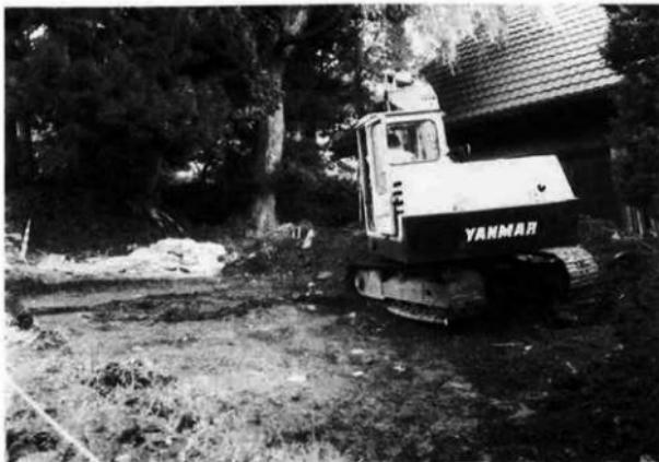
写真3 重機による表土除去
