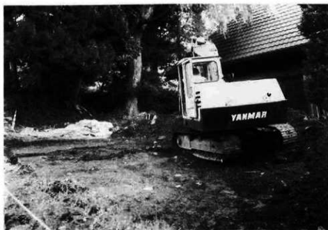
写真3 重機による表土除去
