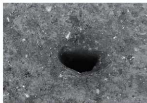
PP1断面 東から
