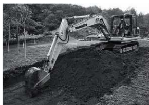
東調査区 重機掘削作業
