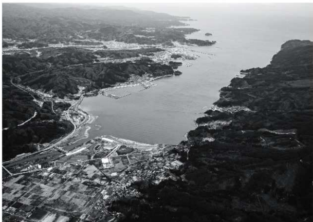
道跡遠景（南から）
