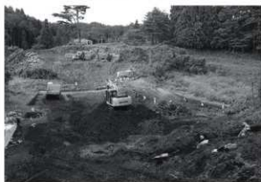
重機掘削状況 南から
