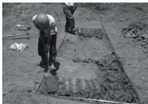
人力掘削作業(1)
