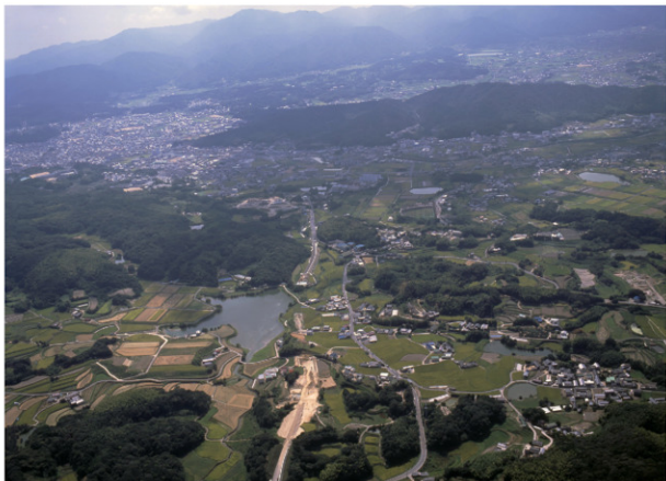
調査箇所遠景（北上空から）
