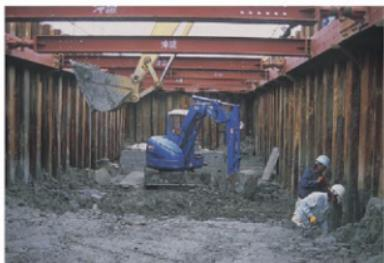
鋼矢板設置後中間層掘削②
