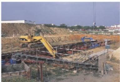
鋼矢板設置後中間層掘削①
