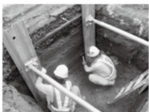
写真 6-3 断面整形作業
