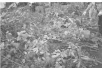
写真5-30 粗朶の上に芯棒を載せる
