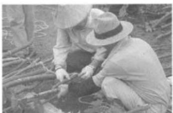
写真5-29 粗朶の根元を縄で縛る
