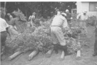
写真5-28 粗朶を土台に載せる
