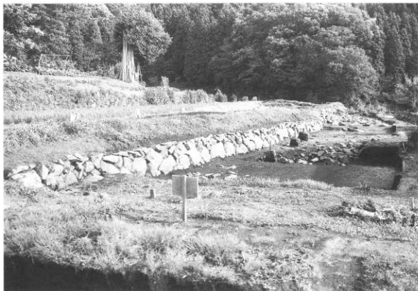
石積み全形 (北から)
