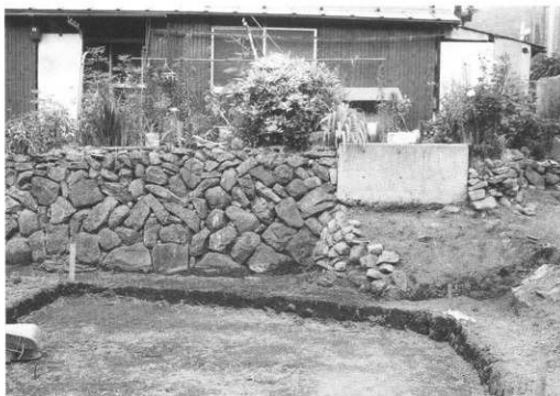
家屋前の石積み状況 (南から)
