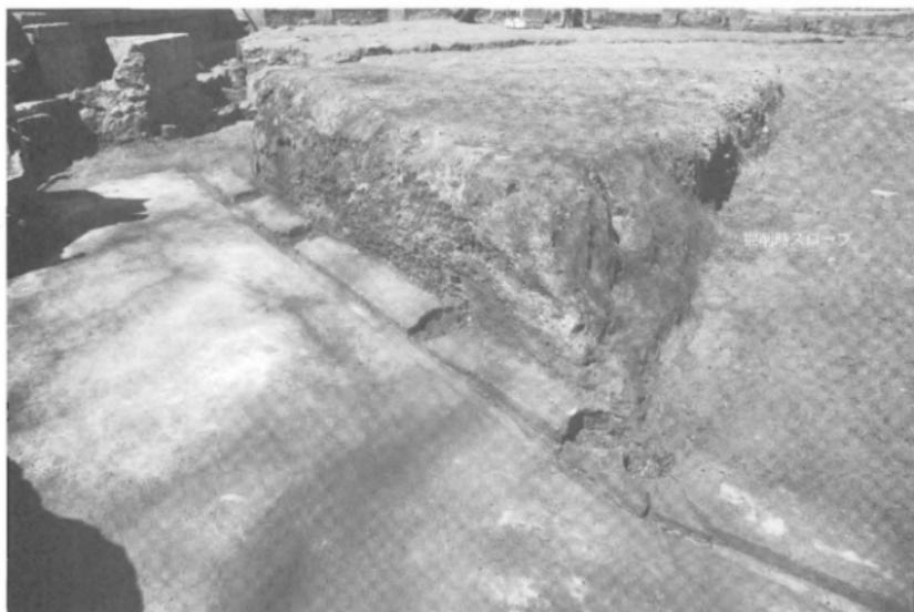
写真7 4 aコンクリート舗装スロープ盤面
