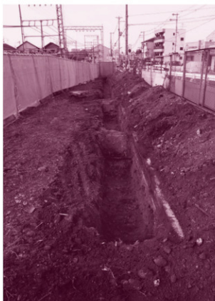
23-2区東部全景(東から)
