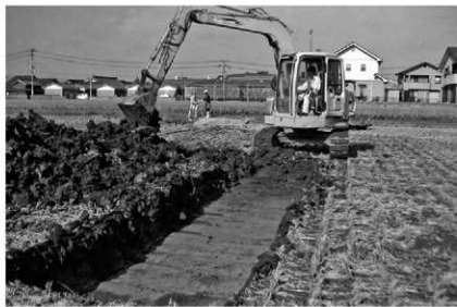
写真2 トレンチ掘削状況
