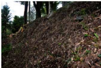
写真10 9面築石清掃前
