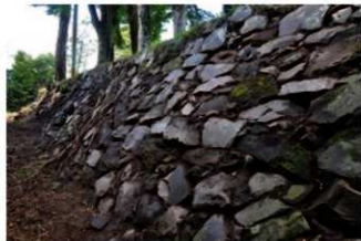
写真9 9面築石清掃後
