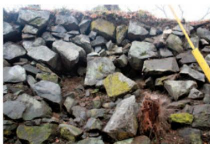
写真11 9面築石欠落部2
