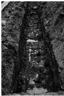
写真22 トレンチ掘削状況
