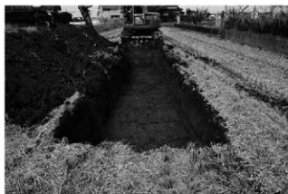
写真24 トレンチ掘削状況
