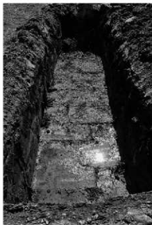
写真20 トレンチ掘削状況
