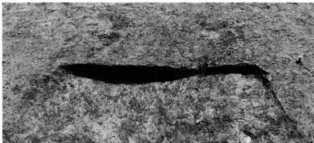
1 熊野松ノ下遺跡 1SD1土層断面状況 (西から)
