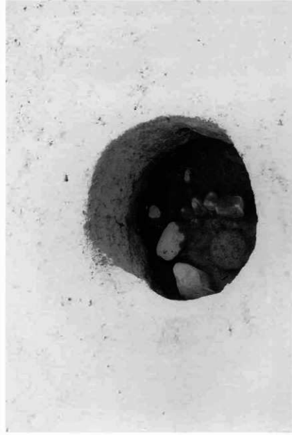
1SE050検出状況（北西から）
