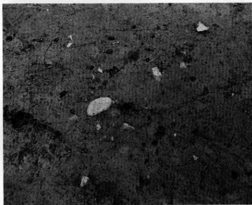
4SX08 除去後 路面部状況 (南から)
