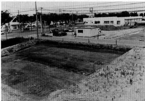
道路遺構部分検出状況 (南西から)
