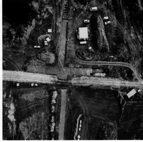
南北・東調査区 全景 （上が北）
