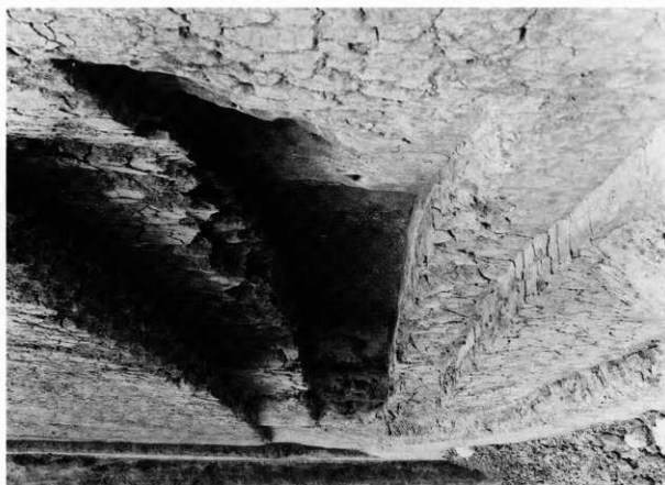
SD001Aトレンチ (西から)
