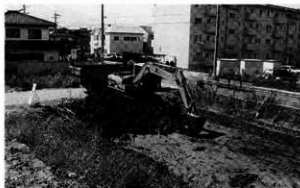
重機表土剥ぎ
