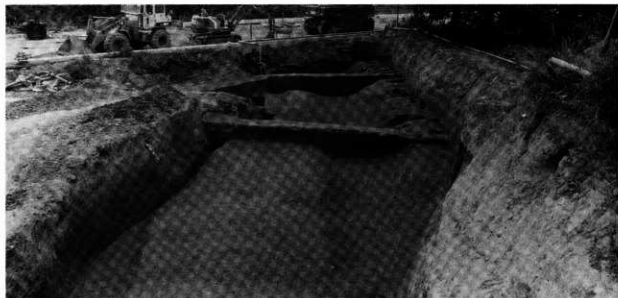
B区-1号溝掘り下げの途上(北東より) 氾濫層(第4層)による埋没直前の状態
