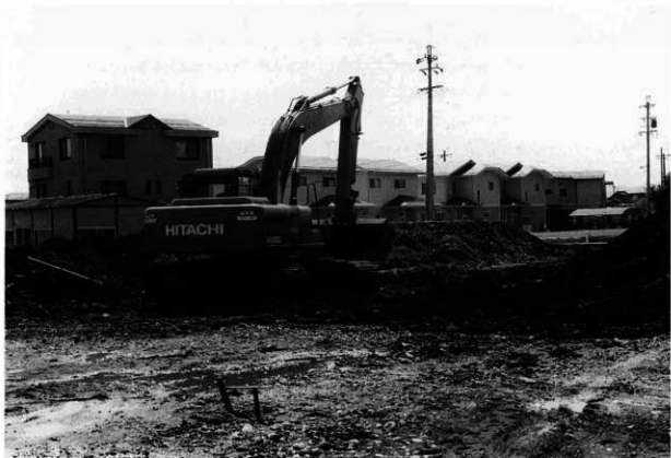
重機稼働状況
