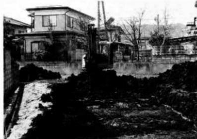
写真1 重機表土掘削
