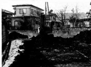
写真1 重機表土掘削
