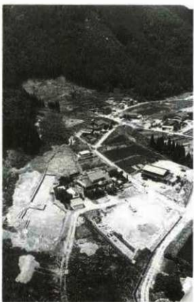
西乙原遺跡 完壁状況
