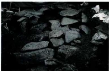
内側に押し出された両側壁石材（奥壁側より）
