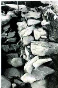
写真 側壁石材崩落の様子
