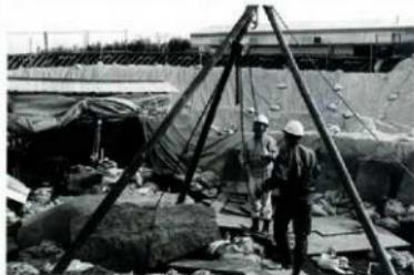
写真 天井石取り外し作業
