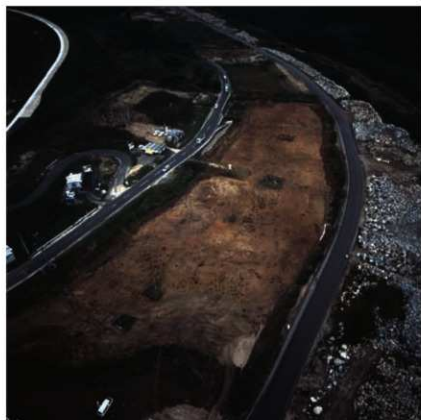
4区北側遠景（南東から）
