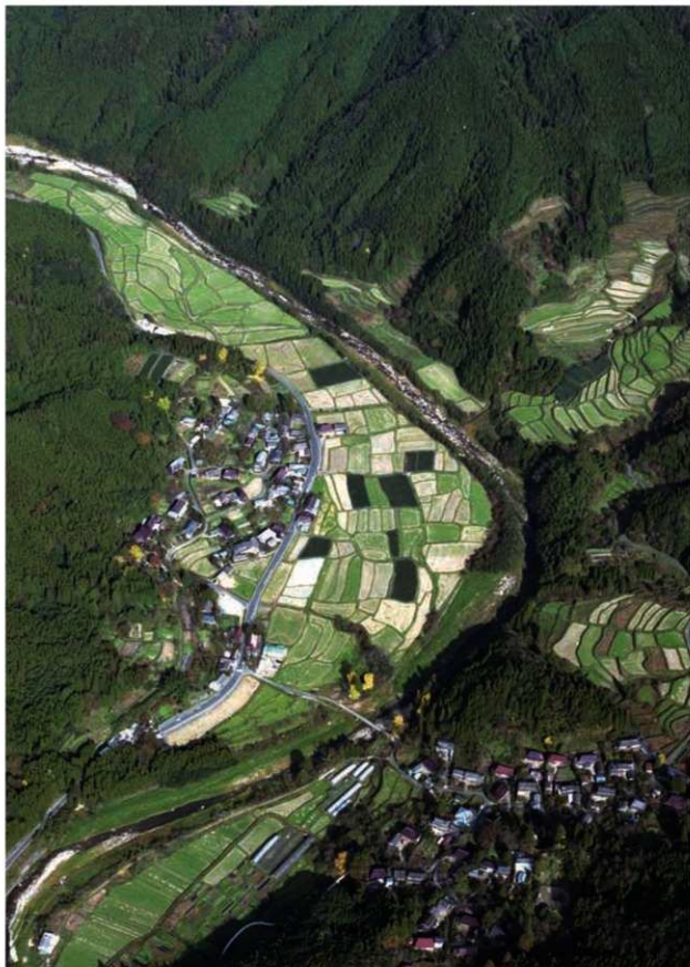
西畑瀬遺跡遠景（南から）（平成4年10月撮影 高瀬川ダム工事事務所提供）
