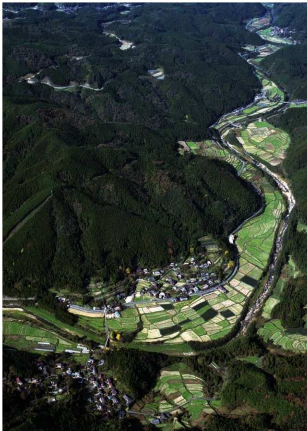
西畑瀬遺跡遠景（南東から）（平成4年10月撮影 高瀬川ダム工事事務所提供）
