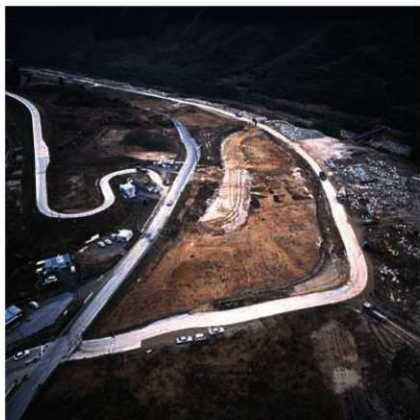
4区南側遠景（南西から）
