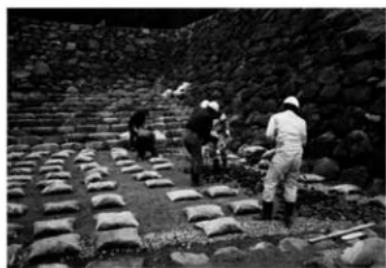
3 表層工（玉砂利工）施工状況
