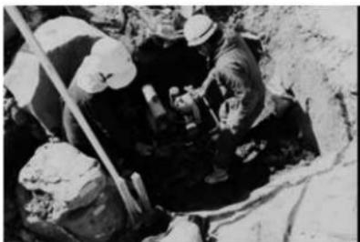
6 石垣③ 根固め施工状況
