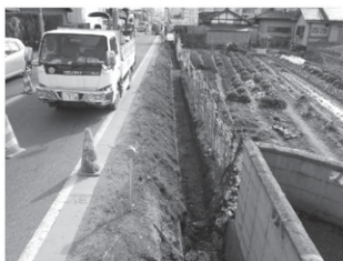
図63 調査区全景(北から)
