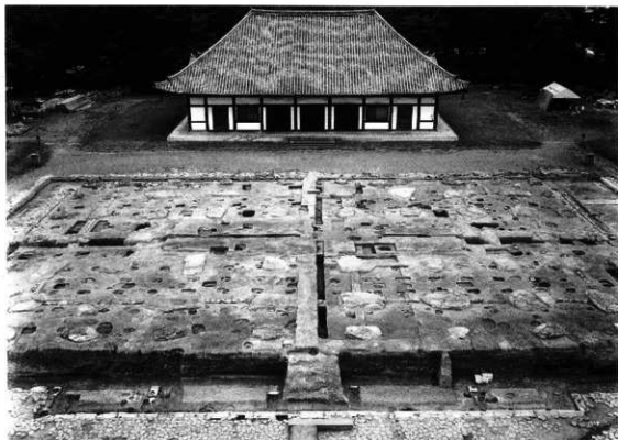
第5図 調査区全景(南より)
