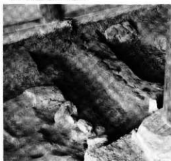
4. 推定北室の西雨落溝
