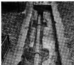
1. 発掘調査で現われた旧導水管(西院)
