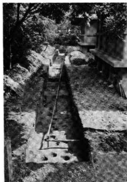
第13図 大宝蔵殿東側トレンチ全景(上:南から、下:北から)217トレンチ
