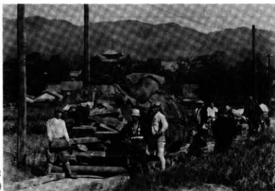
第94図 礎石の運搬状況 (昭和14年10月撮影)
